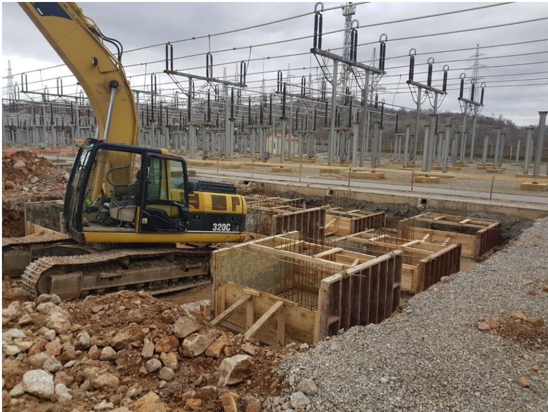
Sl. 1.: Radovi na izgradnji temelja polja =D14 u 220 kV postrojenju
